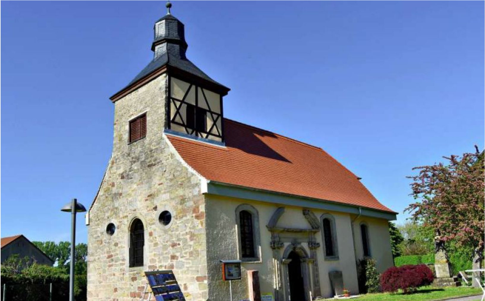
Die Kirche in Tröbsdorf hat dank des Einsatzes vieler ein neues Dach. Das wurde gefeiert.
